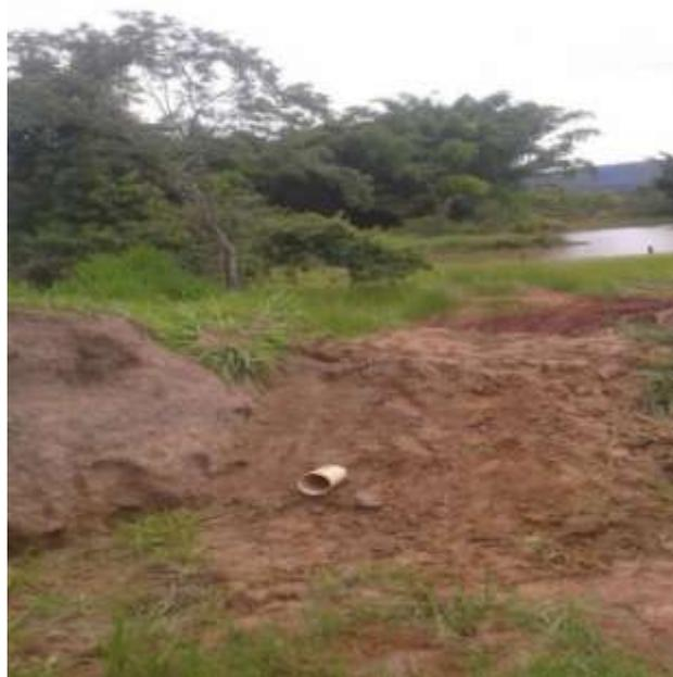
**Figura 3** – Cano de PVC adaptado para retirada de excesso de água
